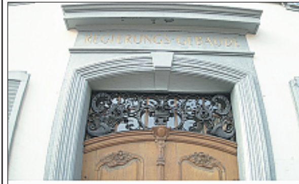
Das Baselbieter Regierungsbau wird geöffnet. Foto: mat.
